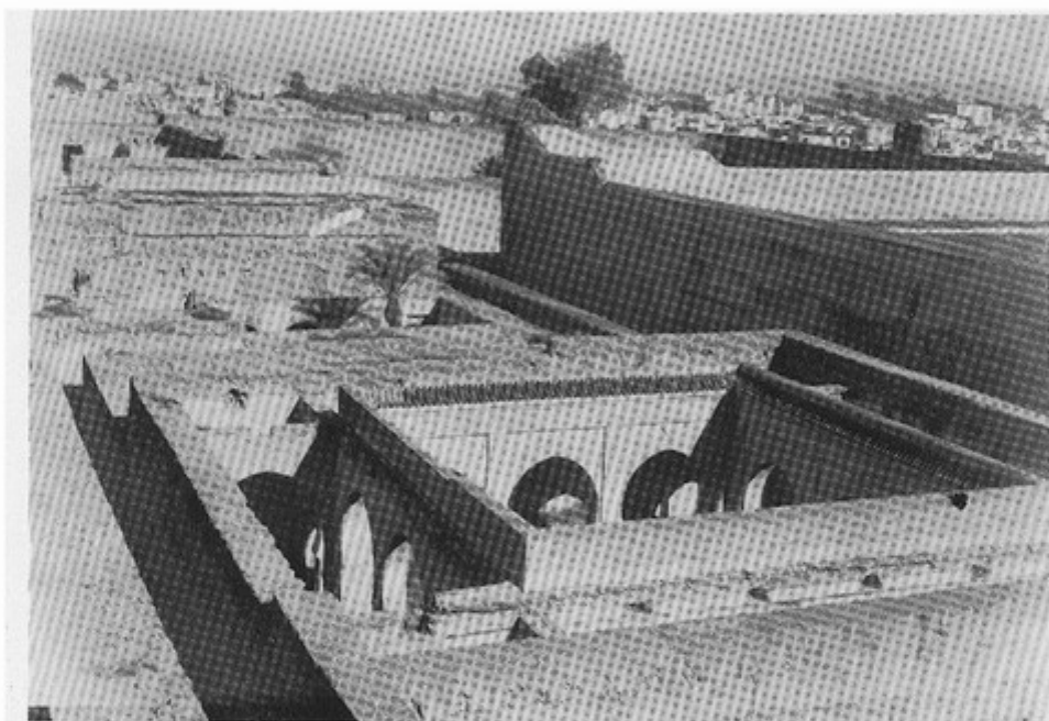
30 - إحدى الجهات المرممة من القصر
